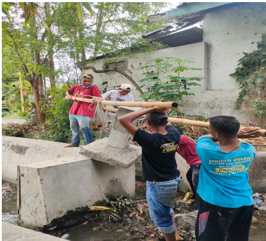
Gambar 3.8 Dokumentasi Kegiatan Pemasangan Patok Batas Wilayah Desa
